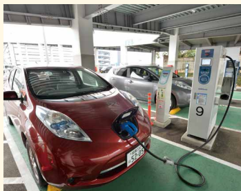
EV charging station (AEON MALL Zama (Kanagawa Pref.))
